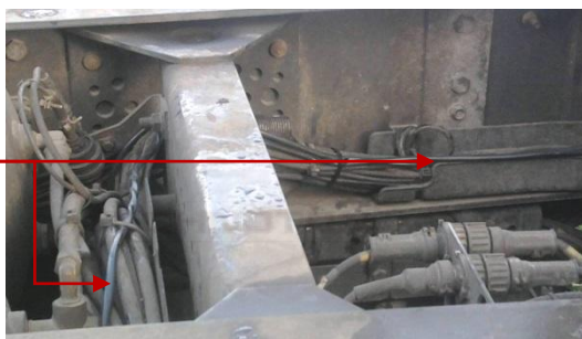
Dibujo 22 – Colocación del cable de señal del DFM
