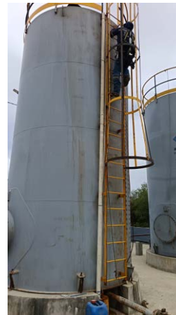
Instalación del sensor de nivel de combustible DUT-E S7
